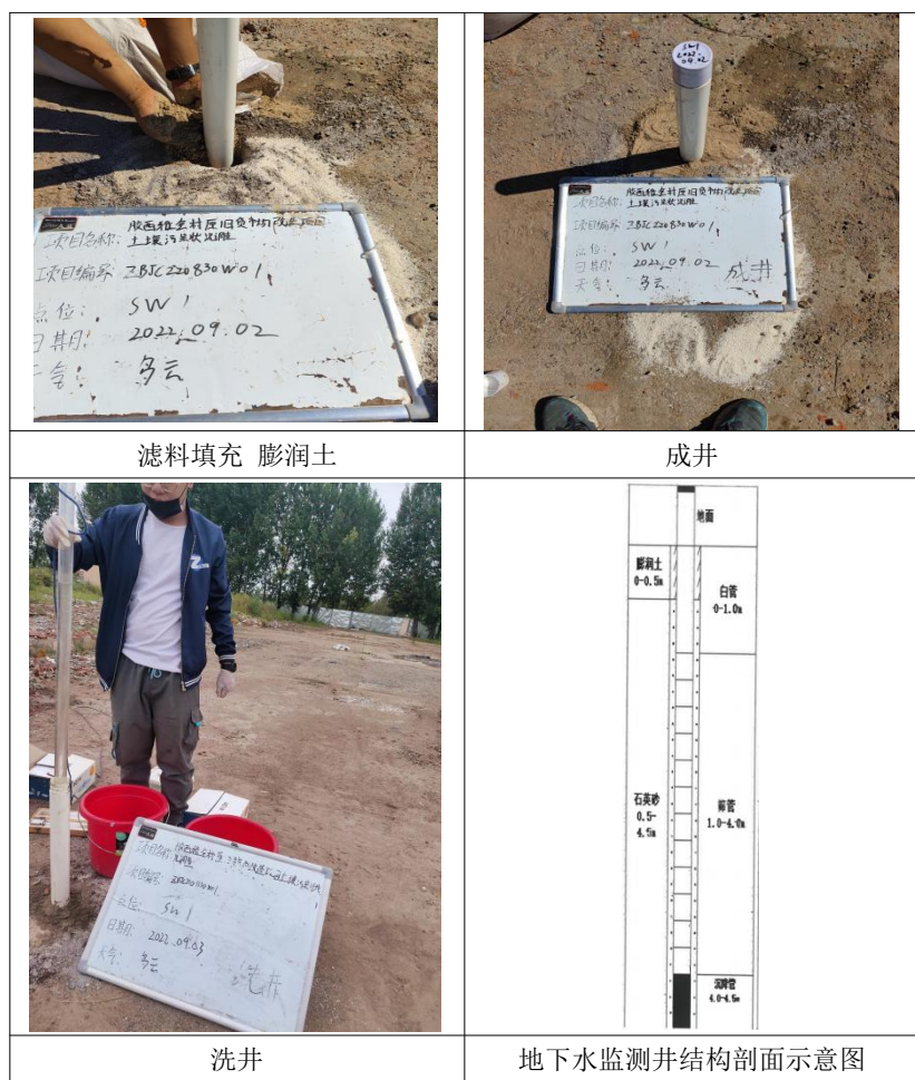
图 5.1-4 地下水监测井
